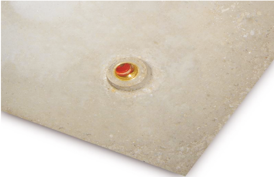
Малюнок 3. Вигляд на спринклерну розетку після замонолічення в бетон.
