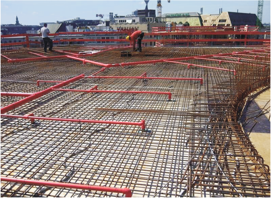
Малюнок 1. Підготовка трубопроводів для замонолічування в бетон
