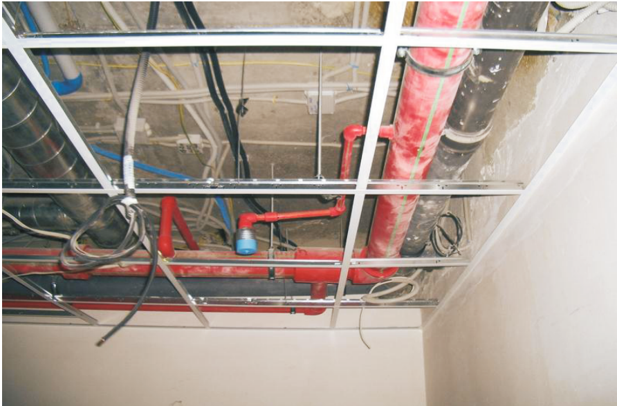
Малюнок 4. Вигляд на спринклерну розетку при монтажі за підвісною стелею
