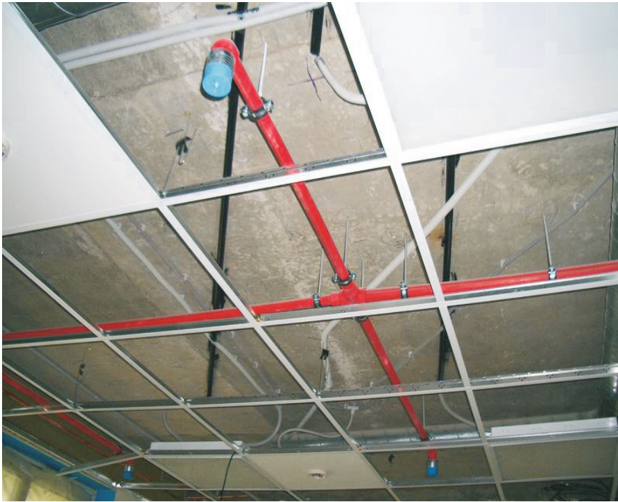
Малюнок 5. Вигляд на спринклерну розетку при монтажі за підвісною стелею
