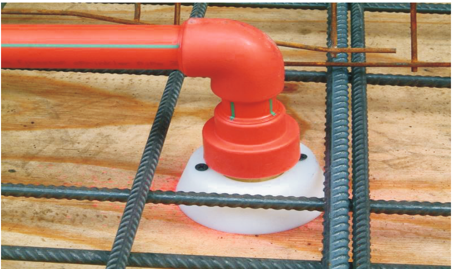
Малюнок 2. Підготовка розетки спринклера для замонолічування в бетон
